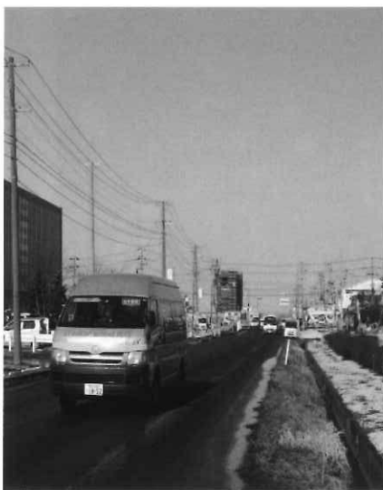
中央1号線整備進行中
