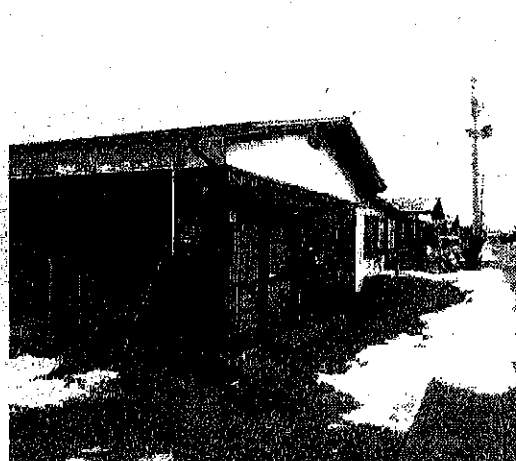
町営矢巾住宅
