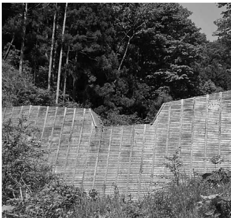
高区排水塔の上流部にある治山ダム
