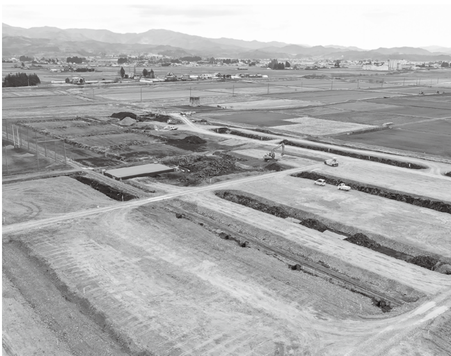
宅地造成工事が始まった田中地区 (不来方高校南側)
