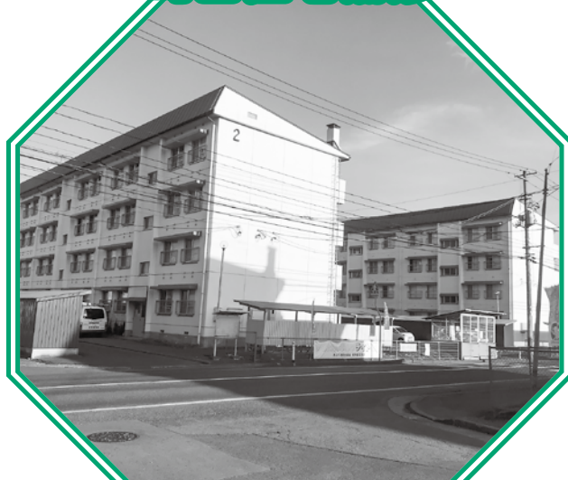
三堤住宅1号棟の屋根補修 3760万円
