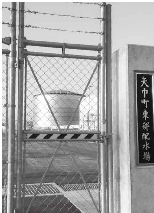
東部配水場のタンク（藤沢行政区）
