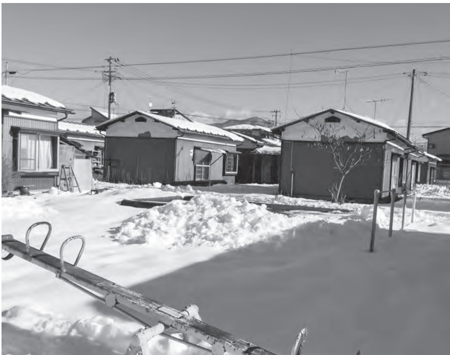
建て替えが望まれる高田住宅
