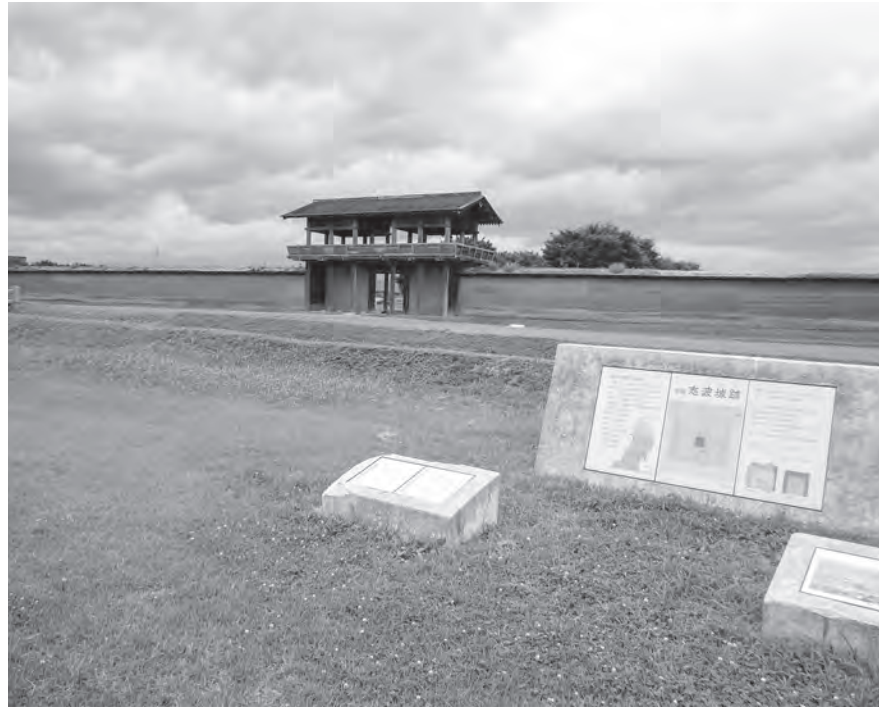
史跡志波城の城柵 (盛岡市)
