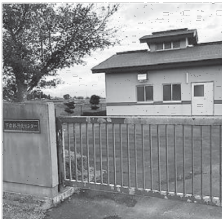
公共下水道に接続される下赤林処理場
