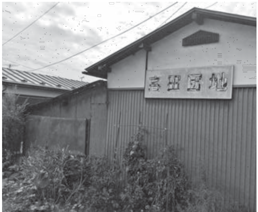
老朽化が進む町営住宅
