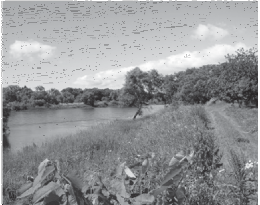
堤防がなく浸水被害が心配される北上川右岸（土橋）
