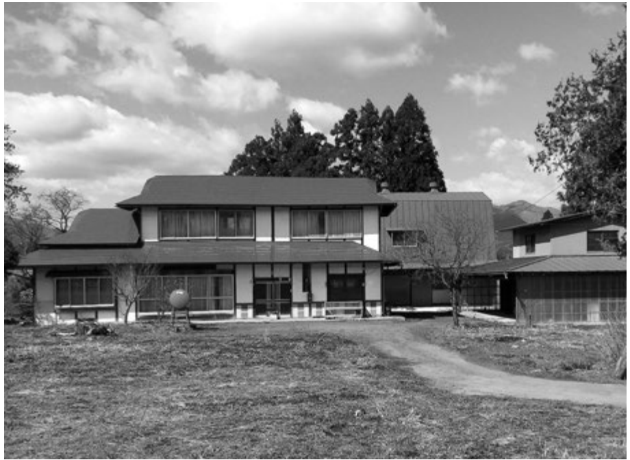
急がれる空き家対策
