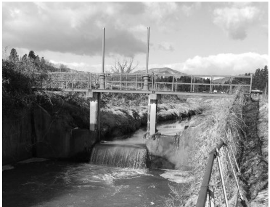
現在使われていない頭首工（宮手川）
