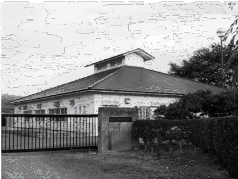
農業集落排水処理施設
