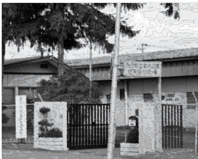
解散により町に組み込まれる上下水道施設 (盛岡市・矢巾町都市計画事業等組合 流通センター)
