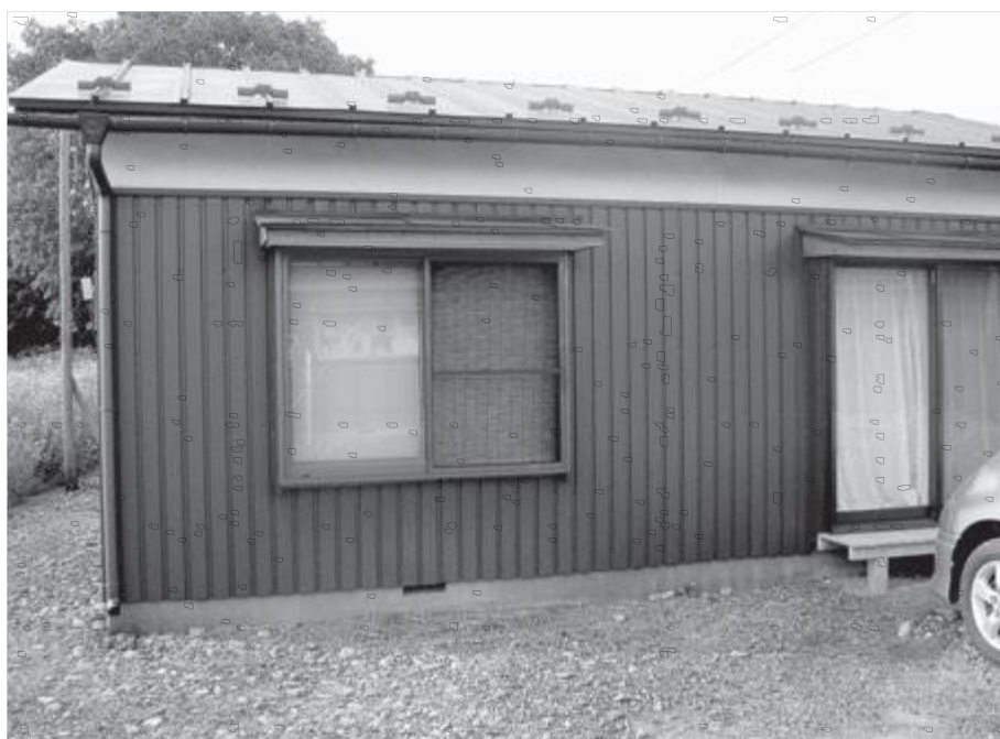
サッシ・網戸を設置し、住みよくなった町営住宅（風張住宅）
