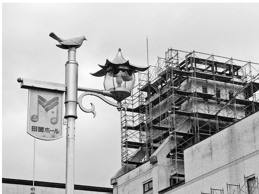
開館30周年を控えて改修中の田園ホール
