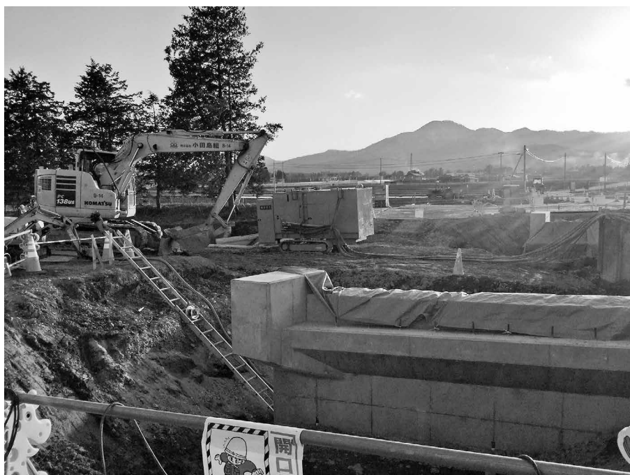
岩崎川復旧工事（六助橋）
