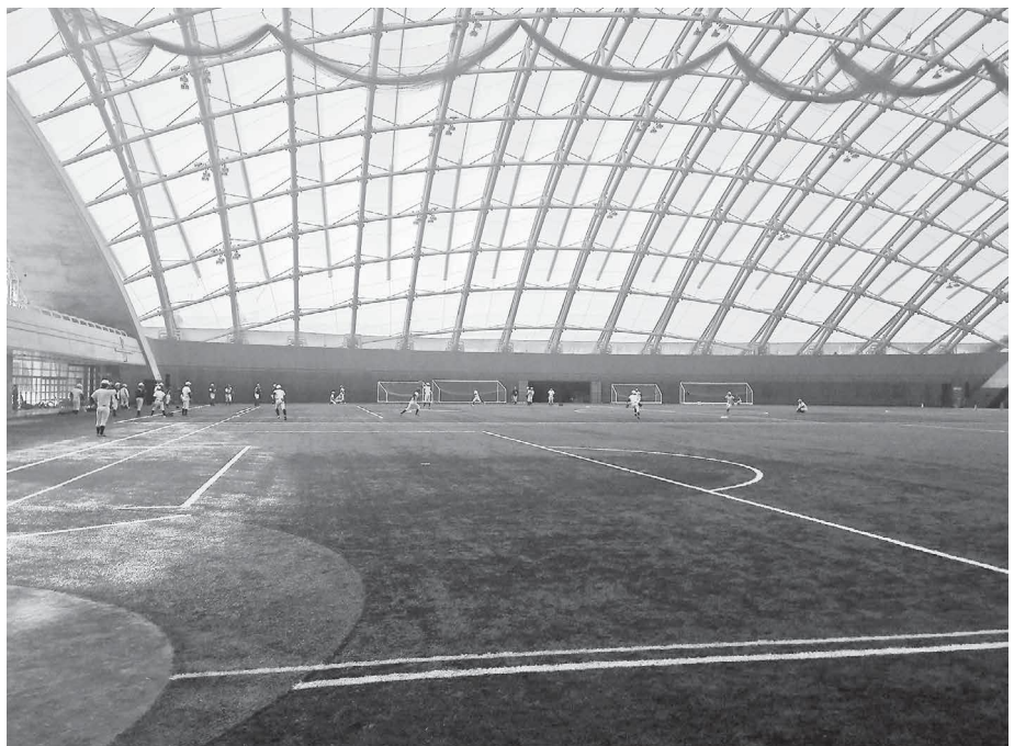
視察した秋田市のドーム施設内部
