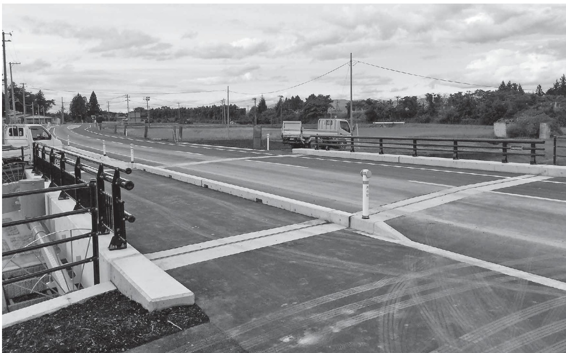
変更契約工事となった田尻橋（煙山地内）
