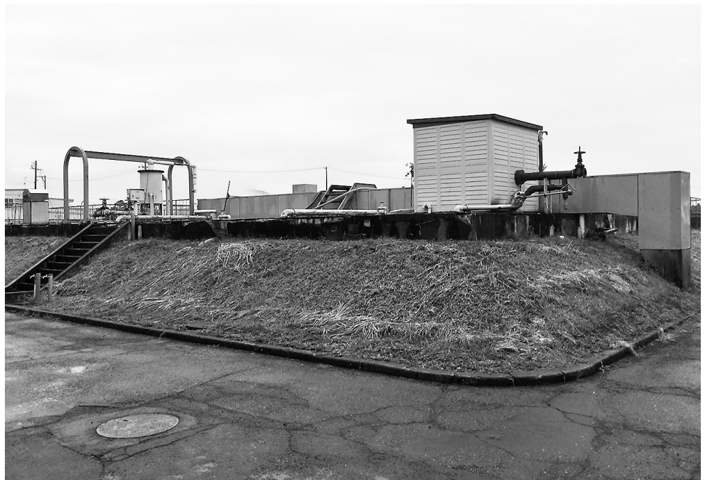
以前利用されていた汚水終末処理場 (流通センター事業等組合)
