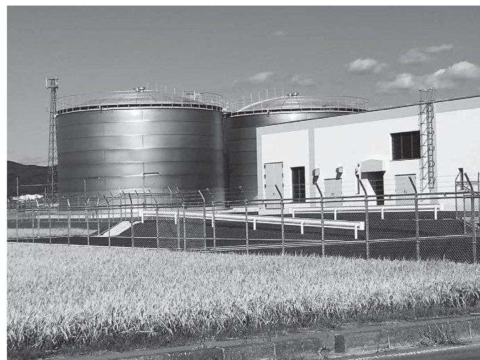
完成間近の新配水場（藤沢）
