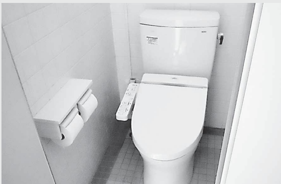
洋式に改修された学校トイレ (徳田小学校)
