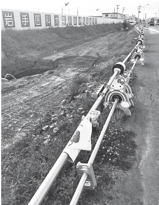
道路改良工事が進められている町道中央1号線(藤沢地内)
