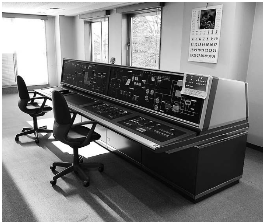
新たな監視装置が設置される東部浄水場
