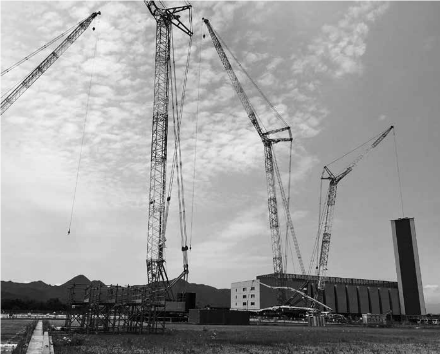
開院に向けて着々と建設工事が進む岩手医科大学附属病院
