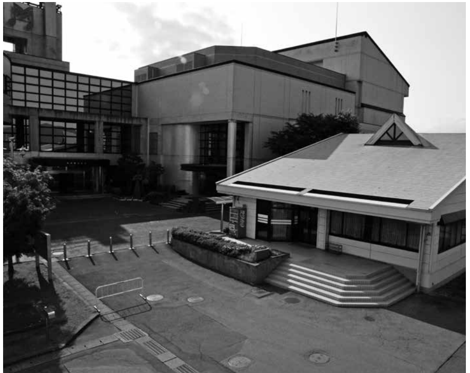
改修予定の町民センター旧食堂(田園ホール隣)
