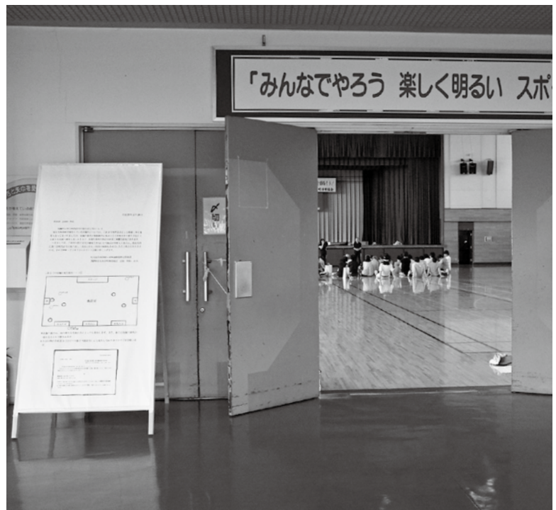
町民体育館では現在雨漏りのお知らせ看板が設置されている
