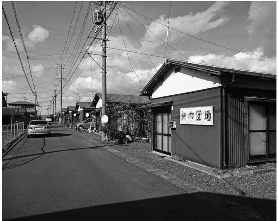
戸建て住宅の集約化が望まれる町営住宅
