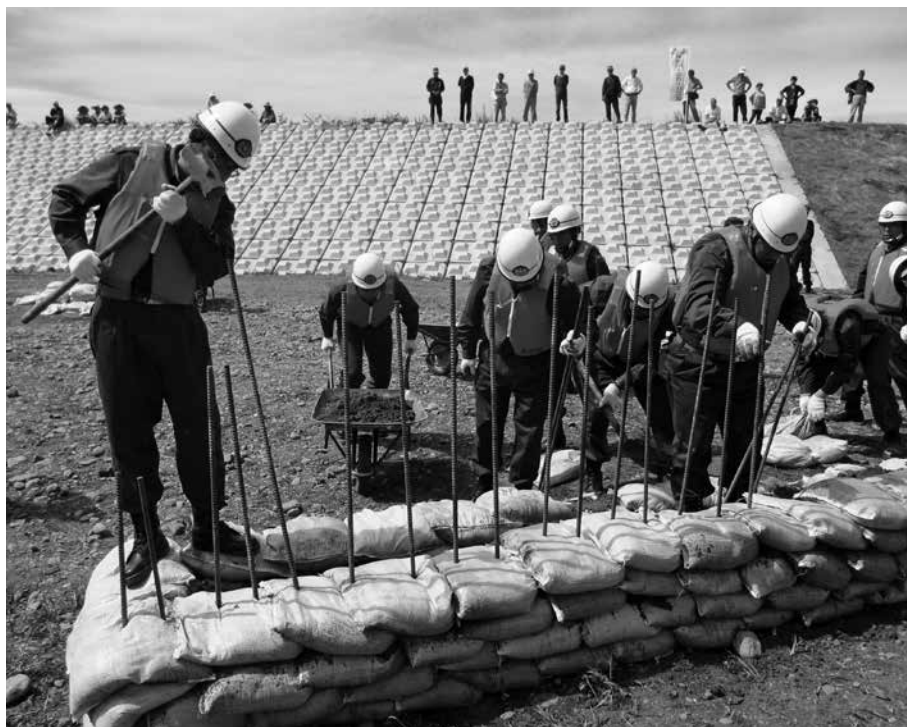
災害に備えて行われた水防訓練(北上川河川敷)
