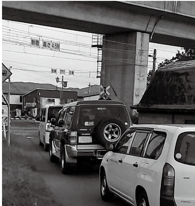
歩道がなく混雑する南矢幅踏切
