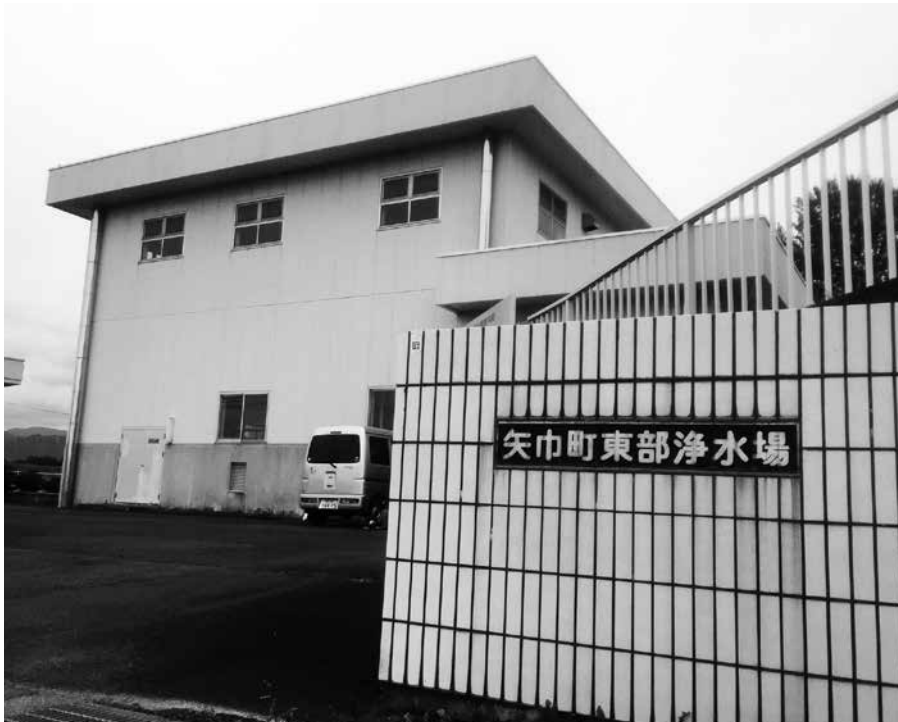
浸水区域に位置する東部浄水場
