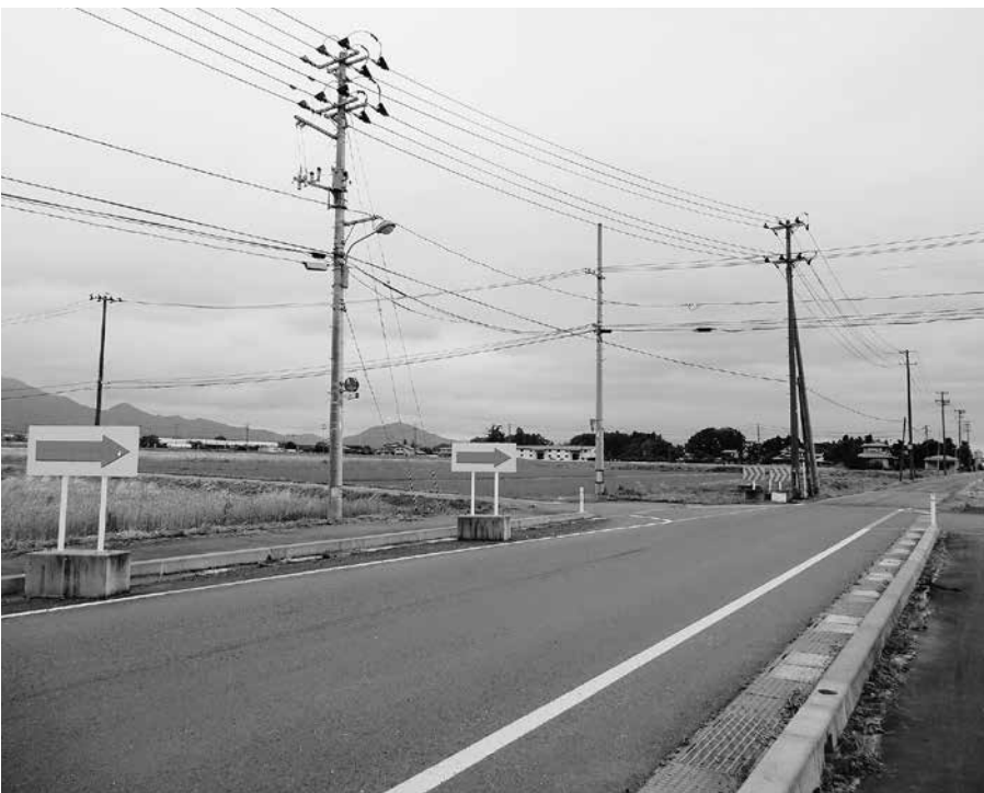
工事予定の町道矢次線
