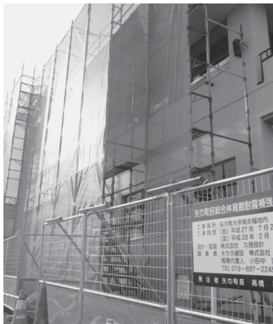
耐震補強工事中の町民総合体育館
