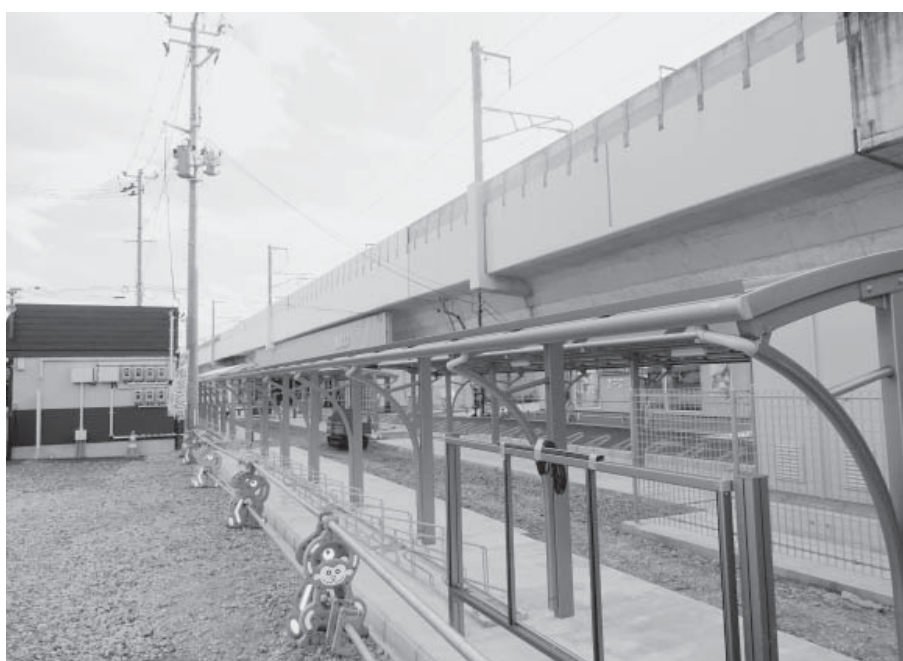
工事中の駅東口南自転車駐車場
