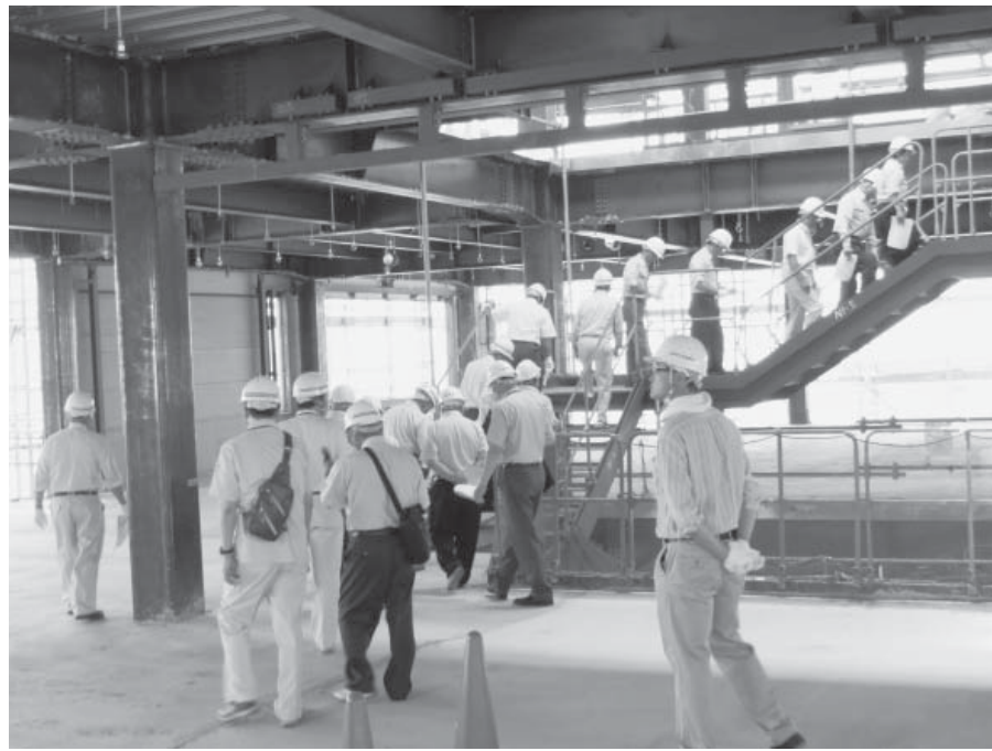
建設中のやはば一く（駅前複合施設）
