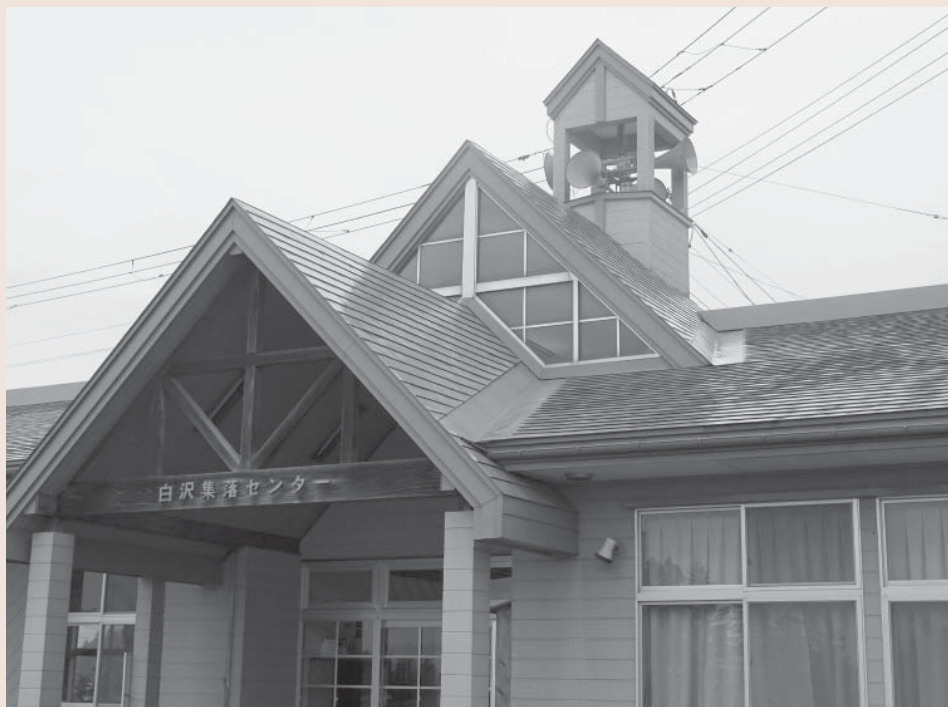
白沢集落センターの屋外放送設備
