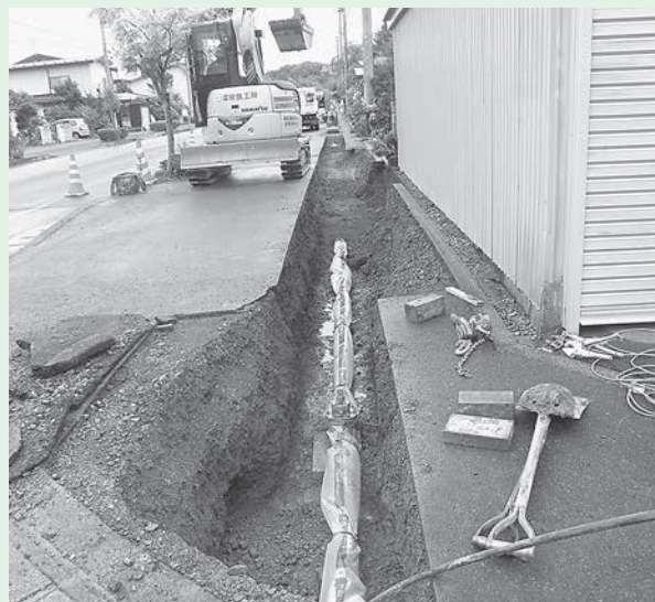
配水管布設替え工事
