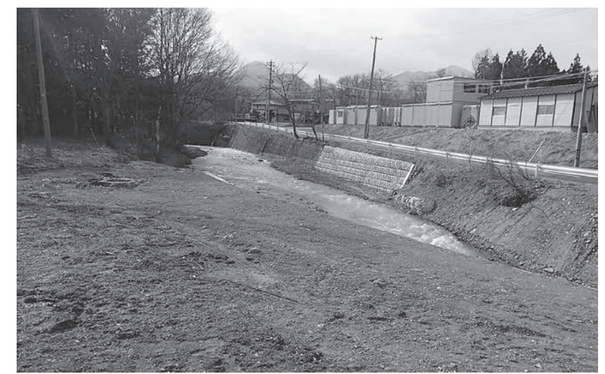
監視カメラが設置される 岩崎川（山王茶屋前橋付近）
