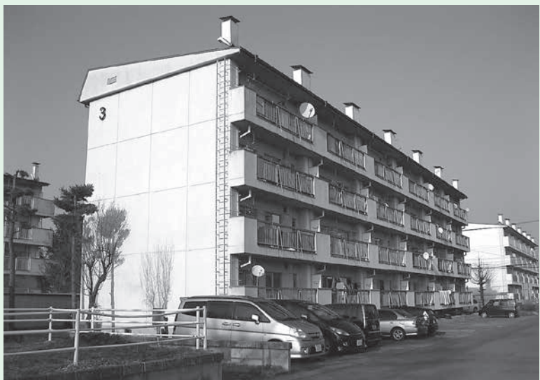
改修が予定されている三堤住宅3号棟
