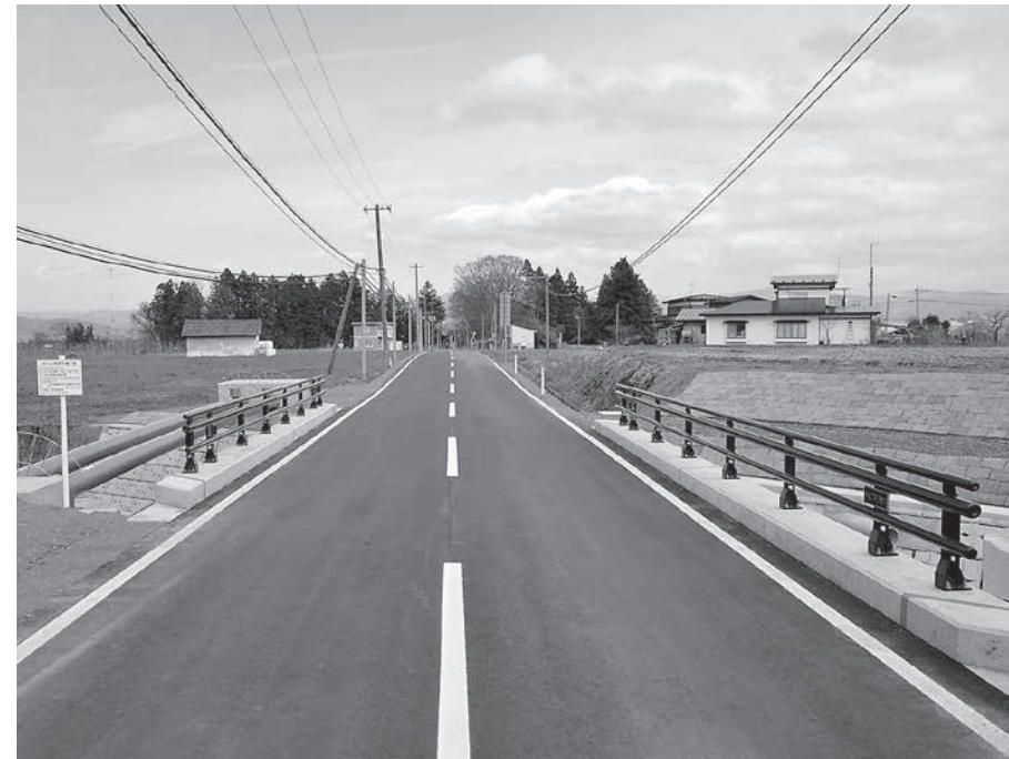
復旧された山王茶屋前橋
