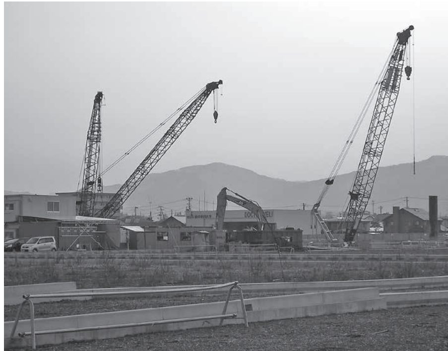
医大附属病院敷地内に建設中のエネルギーセンター棟
