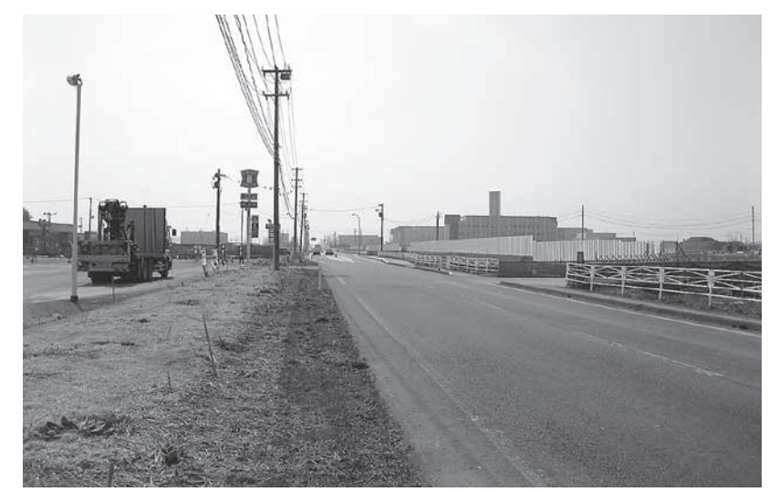
片側2車線の改良工事が予定されている中央1号線
