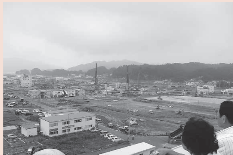
盛土が始まった市街地 (山田町役場屋上より)
