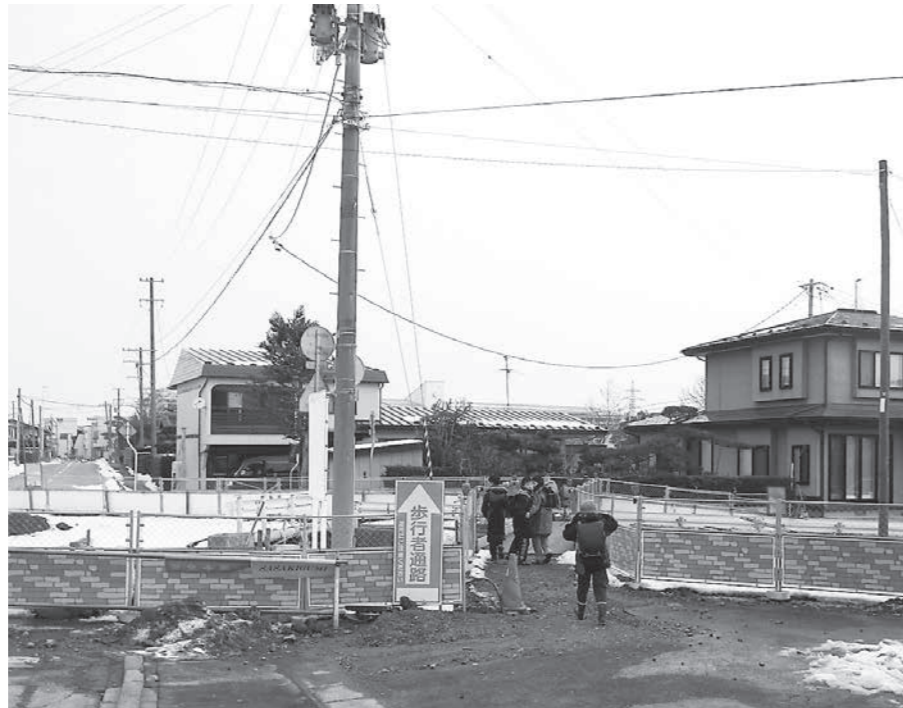
仮設歩道橋が設置された岩崎川橋
