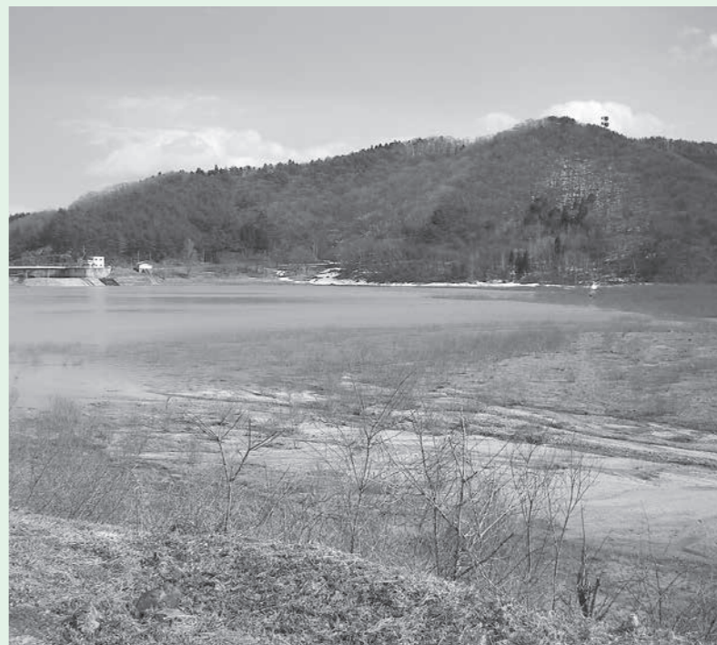
土砂の除去が急がれる煙山ダム
