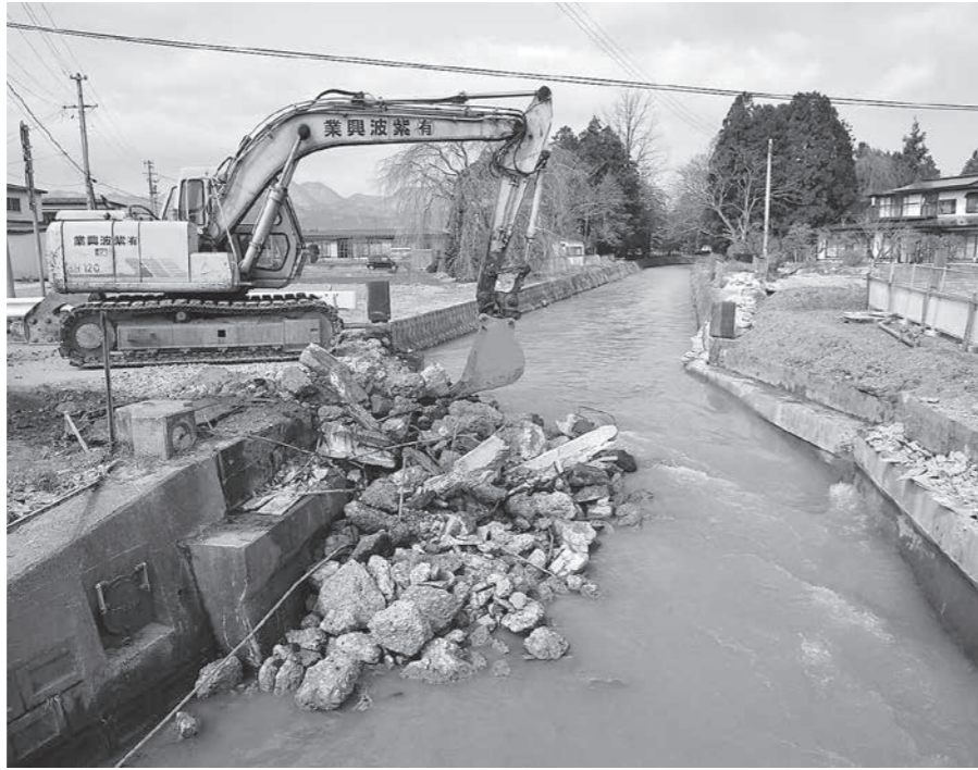
橋げた撤去工事中の岩崎川橋
