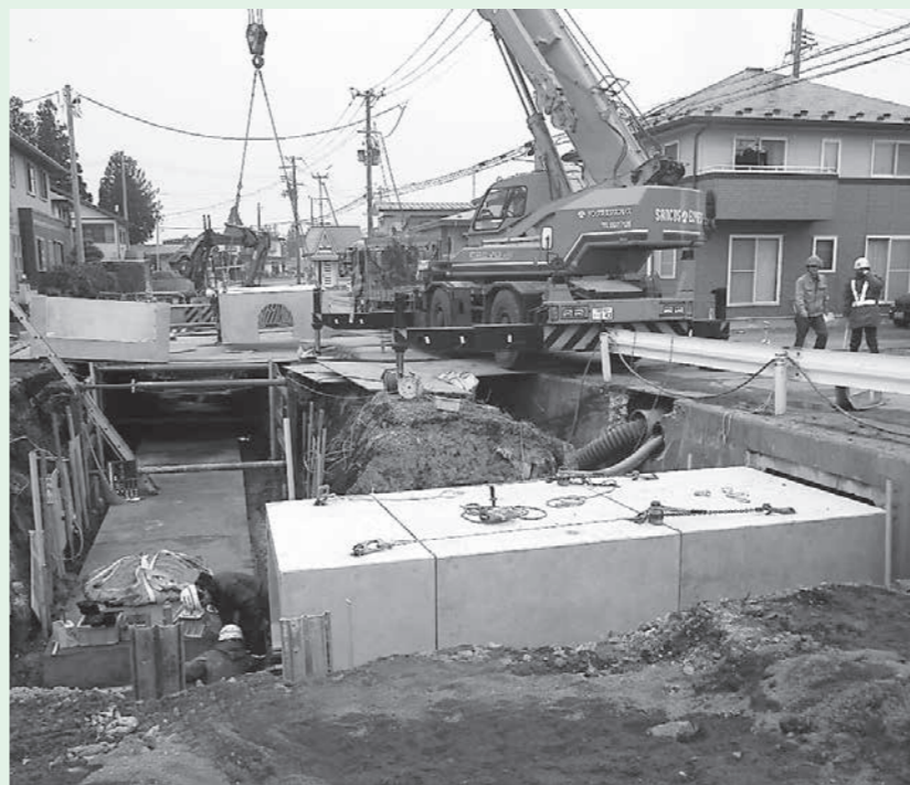
公共下水道事業で改修工事中の車塚
