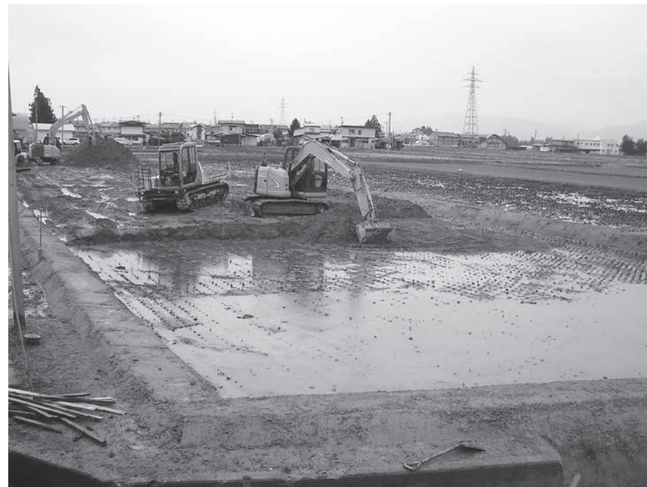
被災農地の復旧工事（新田地区）
