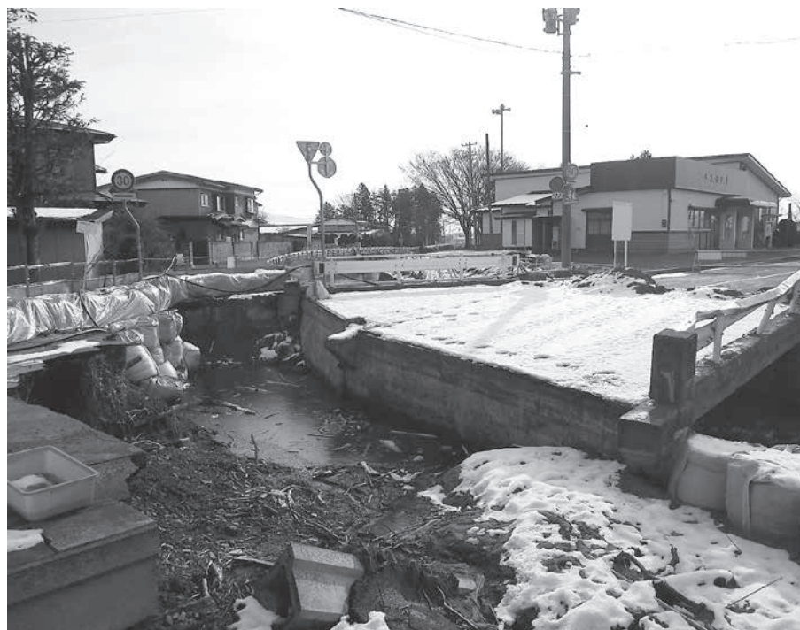
仮設歩道橋を設置予定の岩崎川橋
