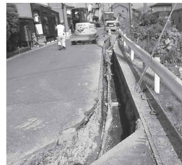
給水管の布設替え工事（南矢幅地区）
