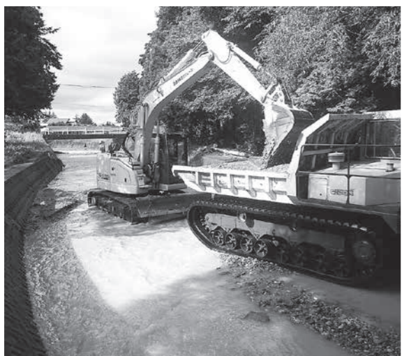
岩崎川の土砂除去
