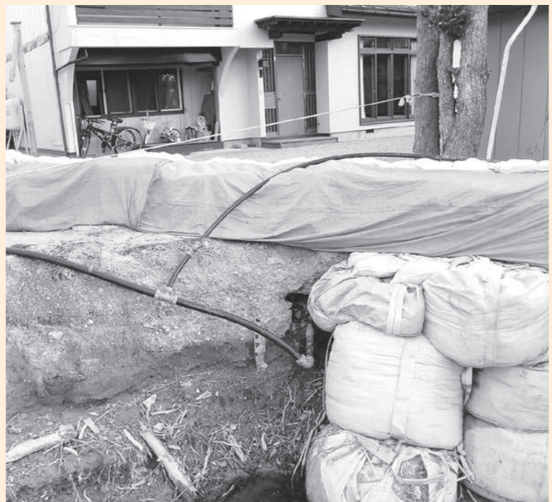
仮復旧中の給水管 (矢次地区)
