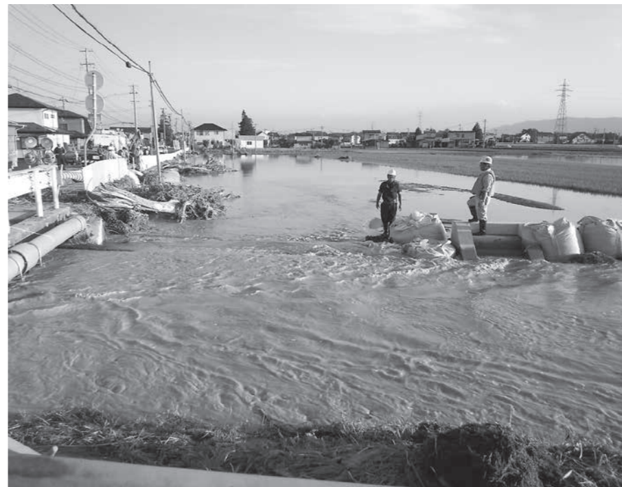
堤防決壊により浸水した水田(新田1区)
