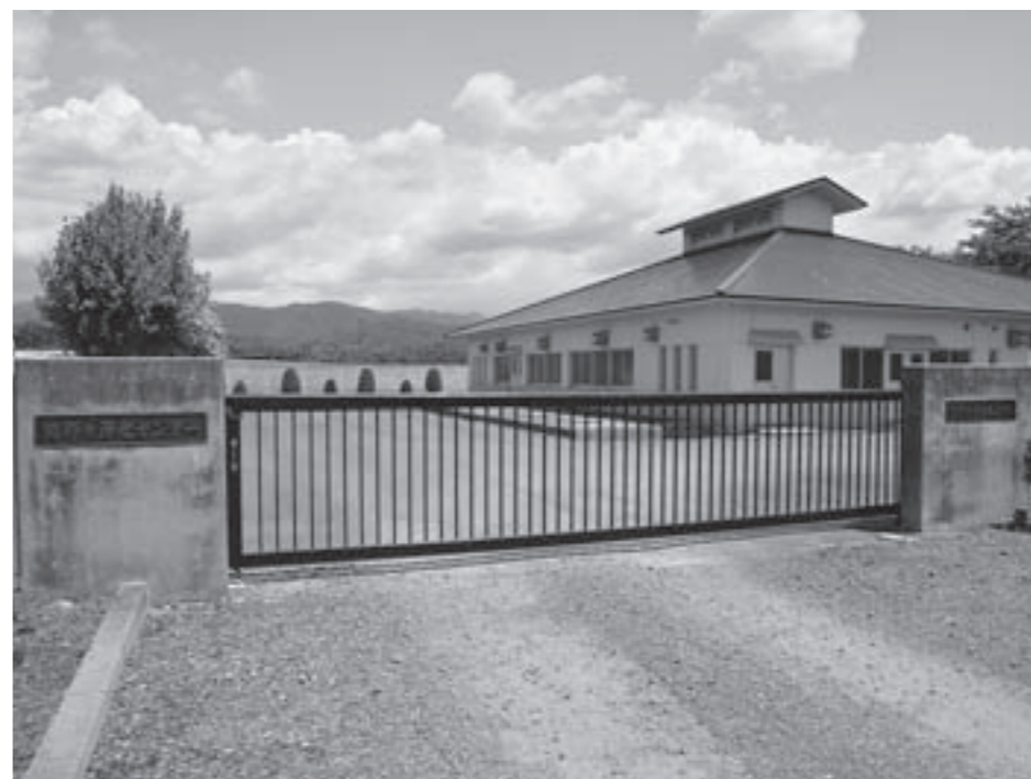
改修が予定されている間野々浄化センター
