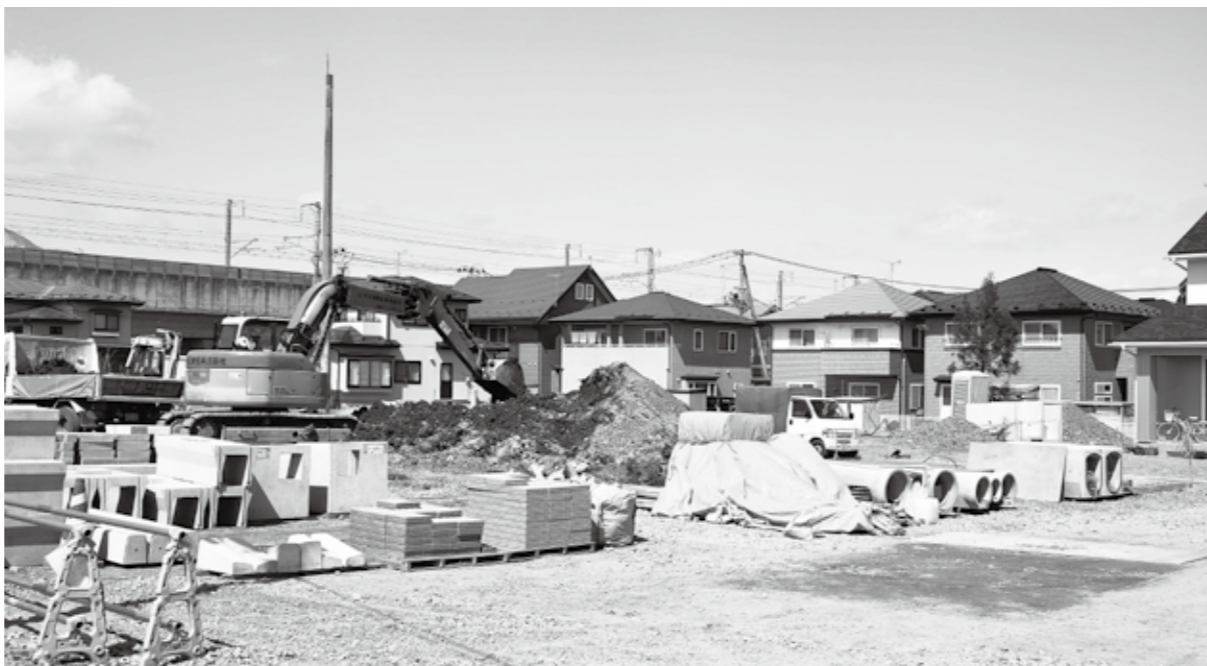
進む駅前地区 順調に工事が
