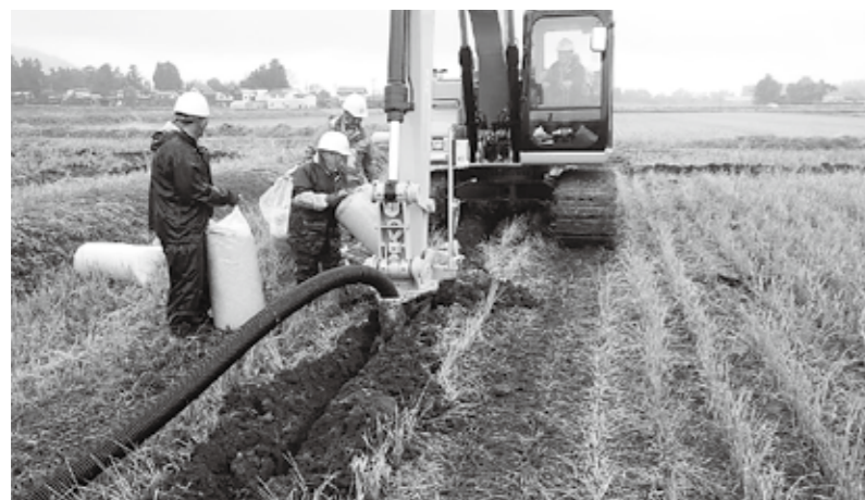
畑作にも対応する暗きょ工事(不動地区)
