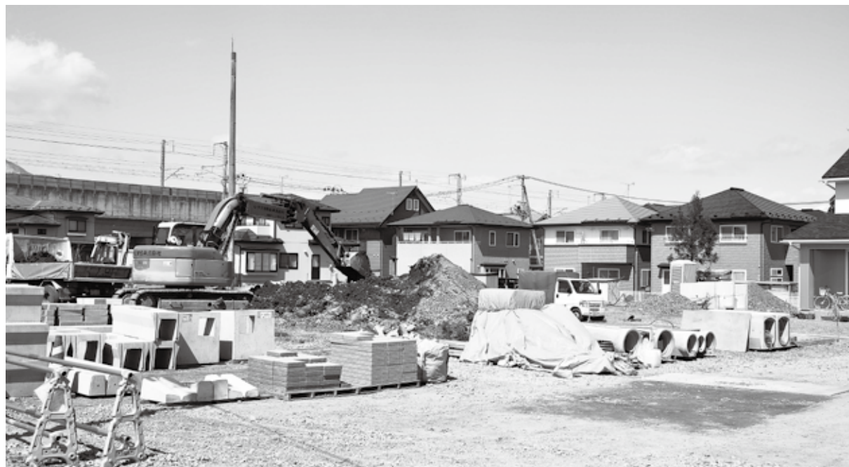
順調に工事が進む駅前地区
