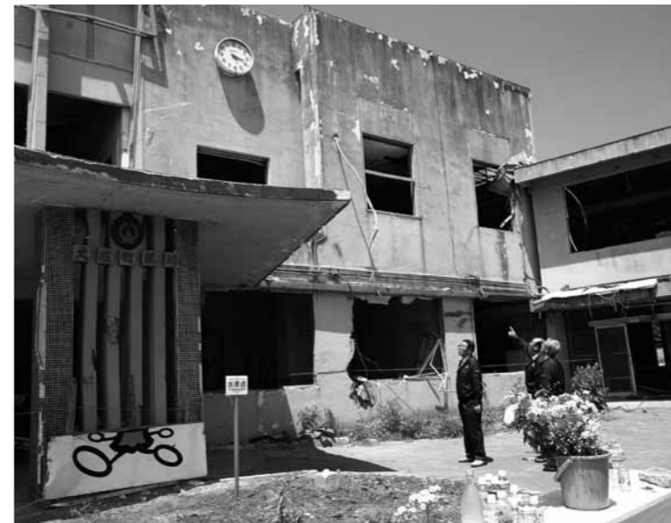
多くの犠牲者が出た大槌町役場
