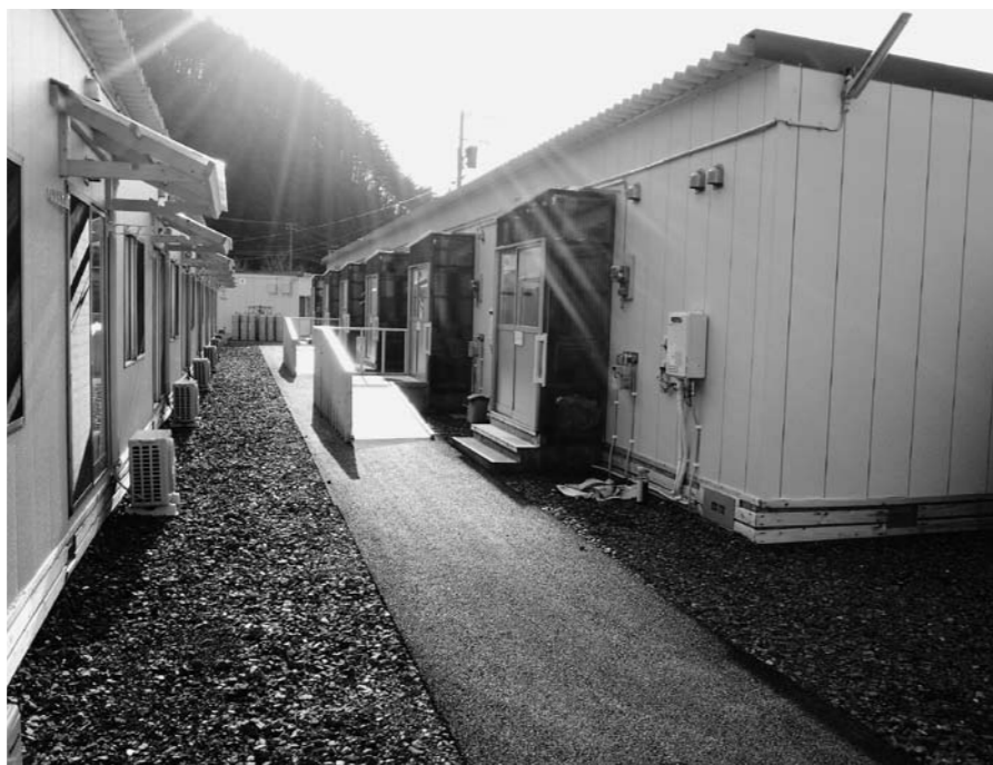
釜石市の仮設住宅
