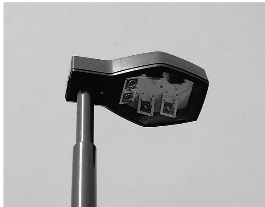
LED街路灯(紫波中央駅付近)
