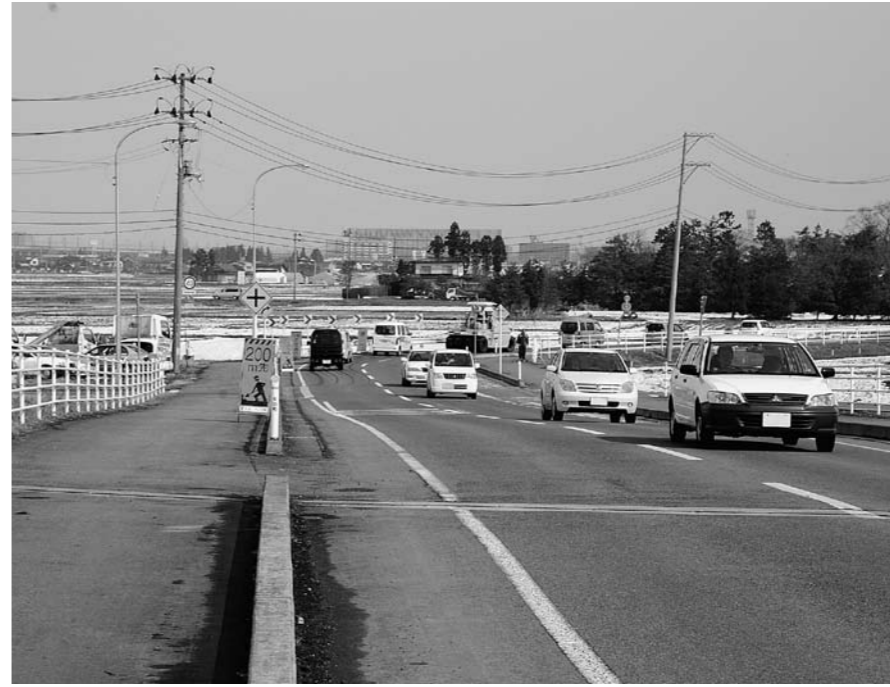
矢巾町側の完成から10年経過しても盛岡市側は…
