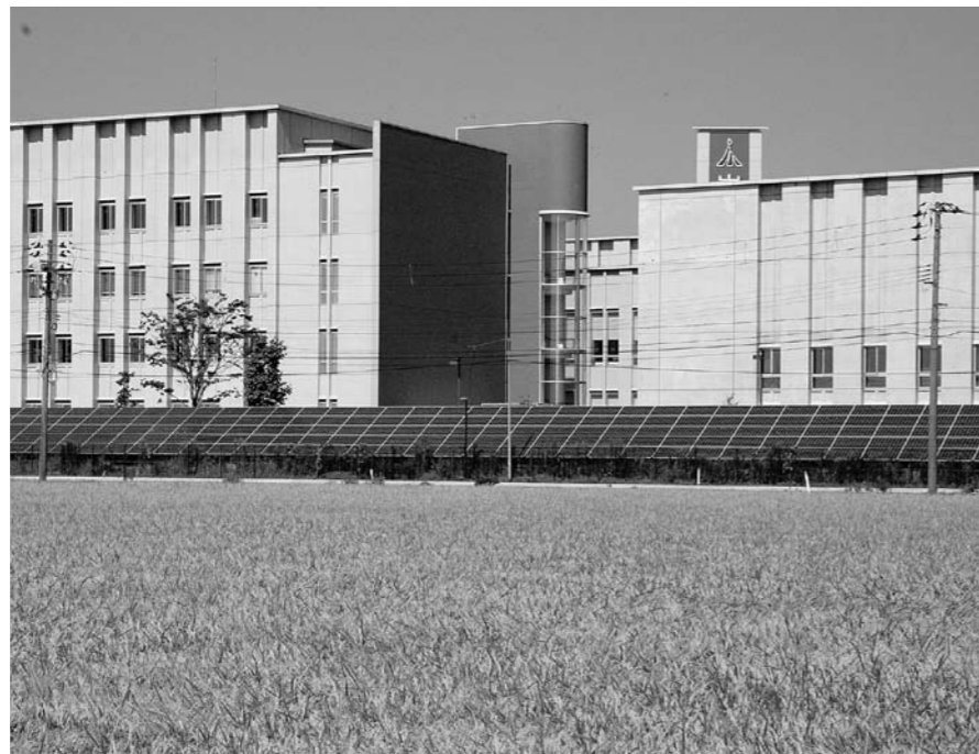
岩手医大に設置された太陽光発電パネル
