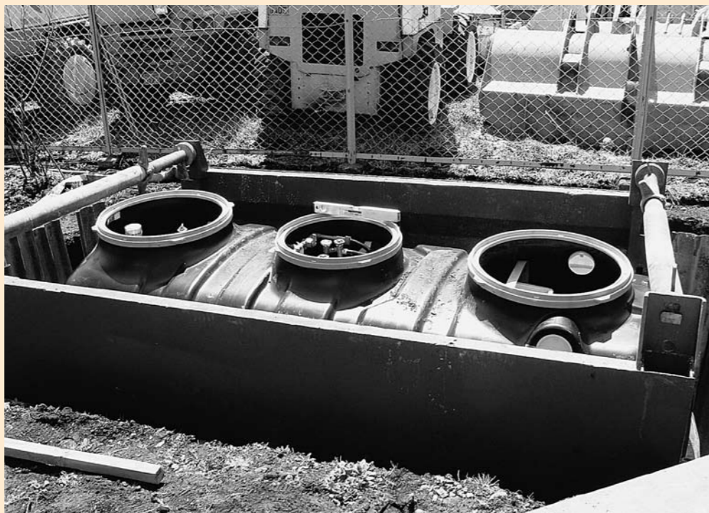
設置工事中の合併処理浄化槽
