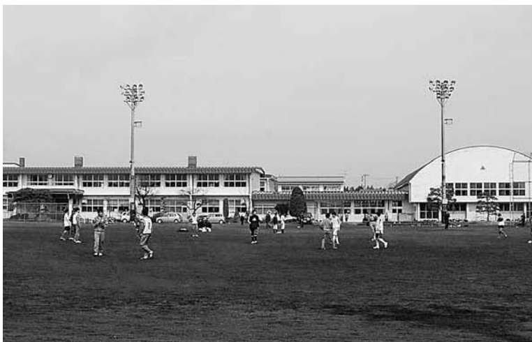
有効活用が望まれる矢巾中学校
