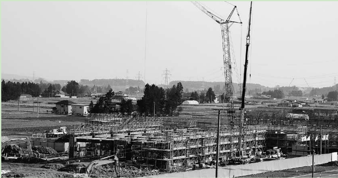
工事が進む新矢巾中学校
