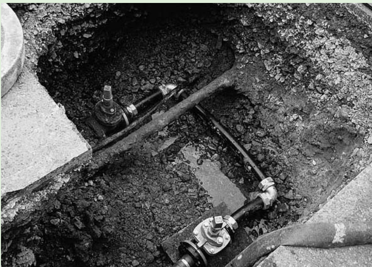
老朽管の更新
