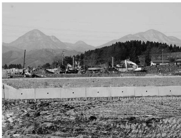
順調に工事が進む矢中中学校
