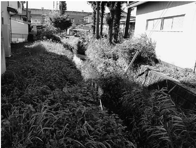
車堰用水路(矢巾1区内)
