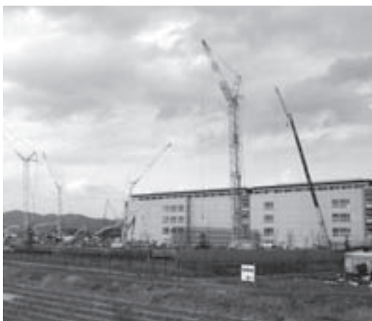
雇用の創出が期待される工事現場
