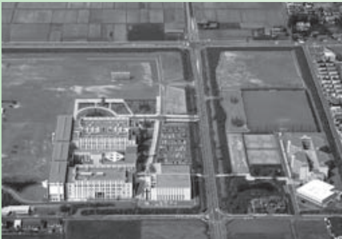
工事が進む医大キャンパス
