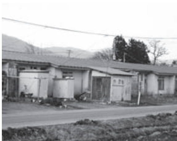
改修予定の町営巾住宅
