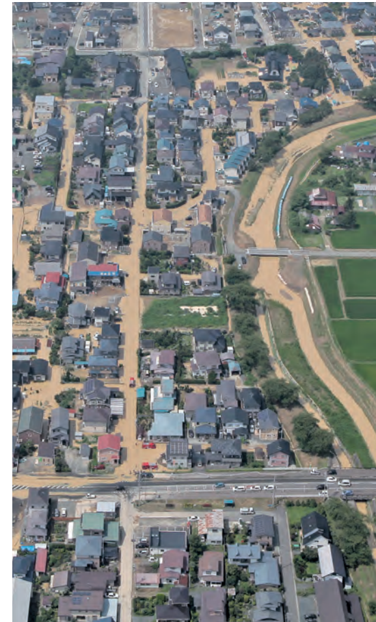
岩崎川の増水により浸水する矢巾1区などの住宅地(平成25年8月10日撮影)
