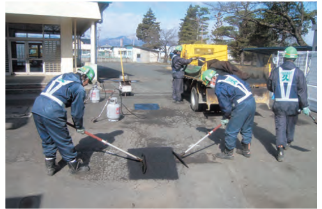
学校敷地内の舗装を行う 佐々木組の社員ら
