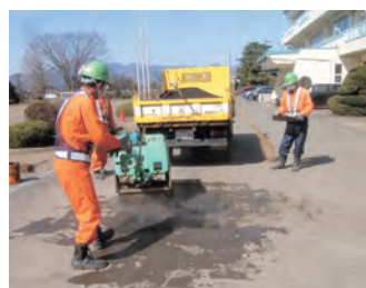
徳田小学校での作業の様子
