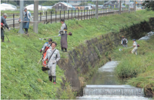
水路の整備を行う地域住民
