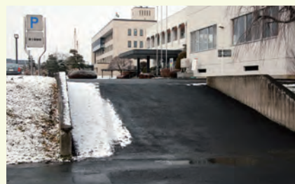
体育館東側の進入口
