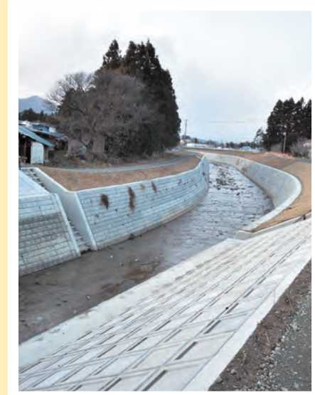
特別緊急事業で改修が行われた岩崎川の一部（六助橋上から北西方面を撮影）
