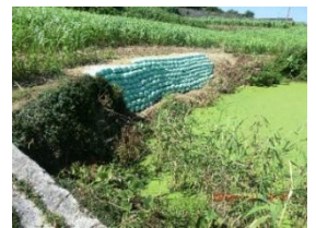
土のうによる崩落箇所の拡大防止
