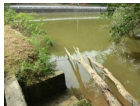
土砂や流木等の撤去
