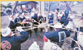
白沢住民自治会は昔の土木作業を再現しました。写真は「亀の子」の作業中で、石に縄を数十本結び付け、石を上下させて建物の地固めを行う様子を再現。
