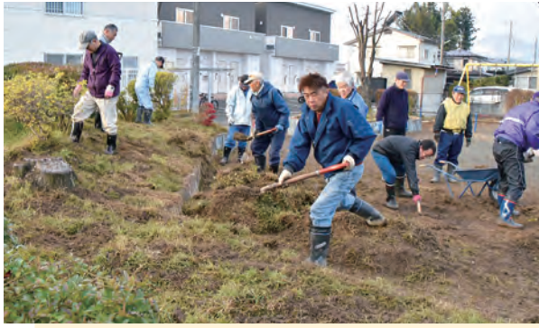
芝生の上に土をかぶせる作業中
