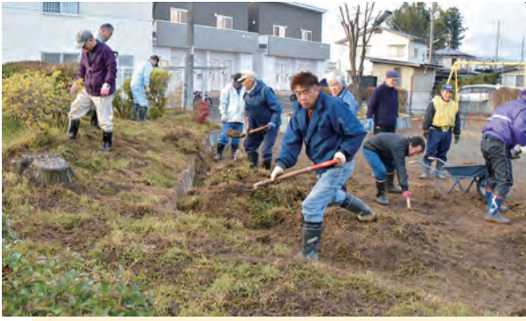
芝生の上に土をかぶせる作業中
