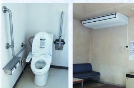
写真右は待合室に設置したエアコン。男子・女子トイレには1つずつ洋式便器が設置されています。
