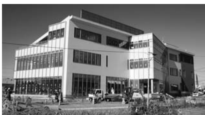
建物南東側からの写真（11/12撮影）
