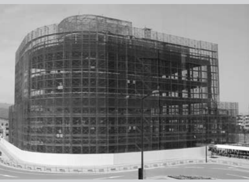
建設中のケアセンター南昌
