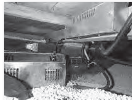
▶床下に積まれた無意味な調湿剤と取り付けられた換気扇
