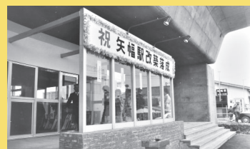
矢幅駅・新駅舎完成
