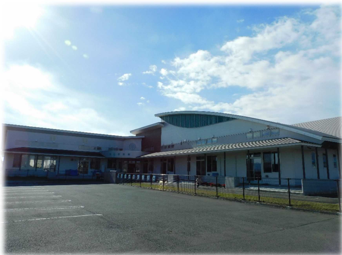
矢巾町立煙山保育園(平成27年建築)
